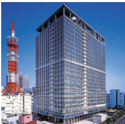
写真1 NTTデータ 堂島ビル
