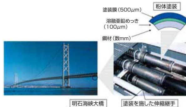
適用例1 橋梁添架設備(明石海峡大橋の伸縮継手)
