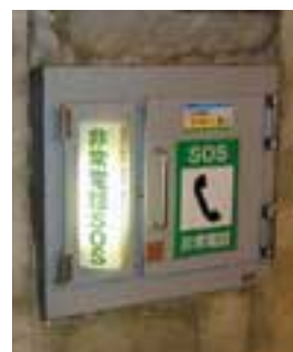
適用例2 塩害地トンネル内非常公衆電話機用収納箱
