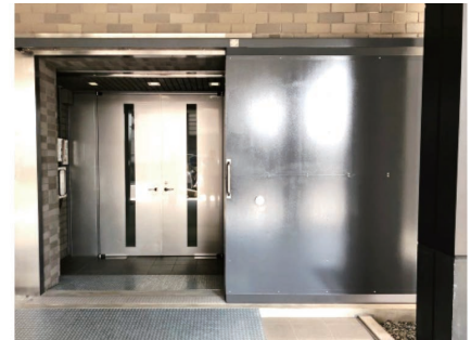
写真1 新設した水防板の例
